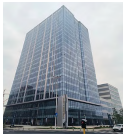
白云金控·未来产业加速基地项目
